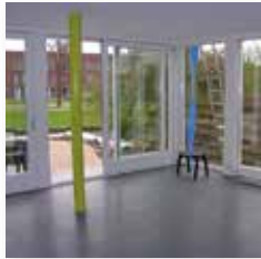
aanbouw, schuifpuien, kozijnen.
