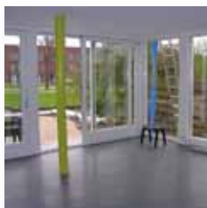
aanbouw, schuifpuien, kozijnen.
